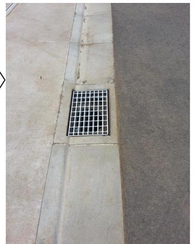
飯山満町1丁目864付近の飯山満南小学校の通学路です。台風26号の時、土砂が流れ出し、甚大な被害を受けました。グレーチングの蓋の網目が細かく、枯葉が詰まってしまう、雨が流れ落ちないので、網目を粗くしてほしいとの要望を住民の方から受けました。
